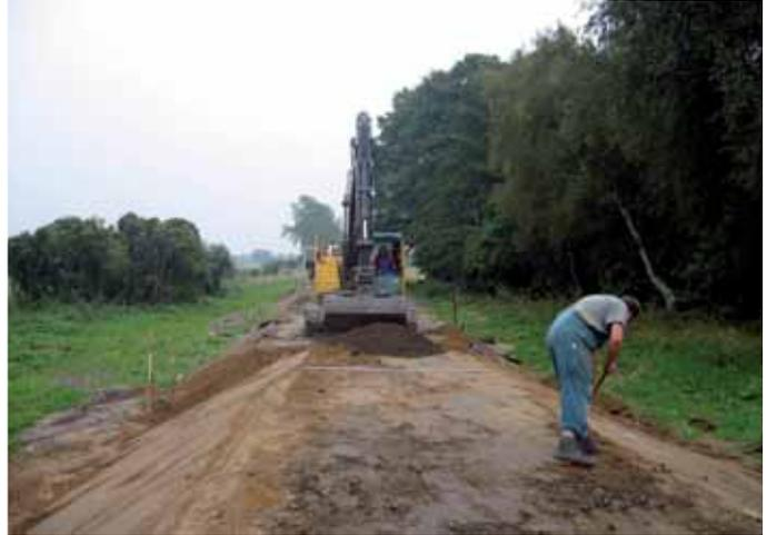
▲ Profilierung des Weges und Aufbringen einer Schottertragschicht
